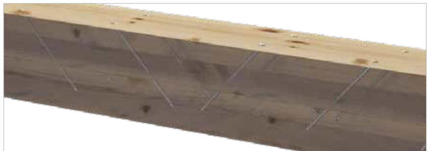
Renforcement par ajout d'une deuxième poutre
