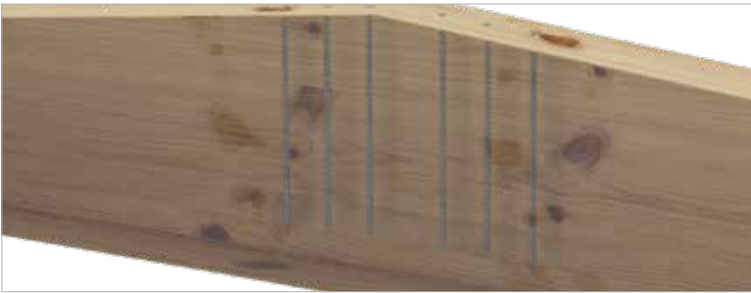
Renforcement avec des vis dans la zone de faite
