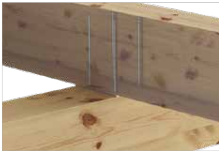
Renforcement à l'endroit du support
