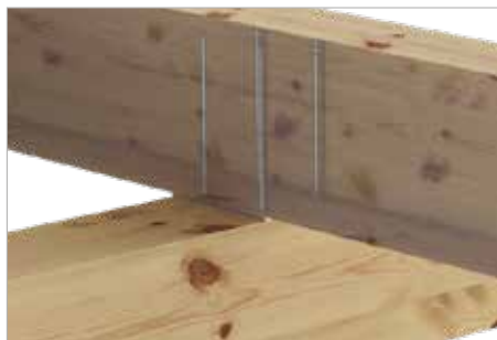
Renforcement à l'endroit du support
