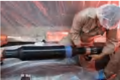
电缆附件安装
