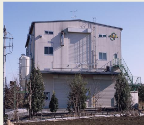
工場外観 埼玉県所沢市
