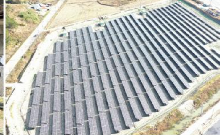
野立架台 韓国3.1MW
