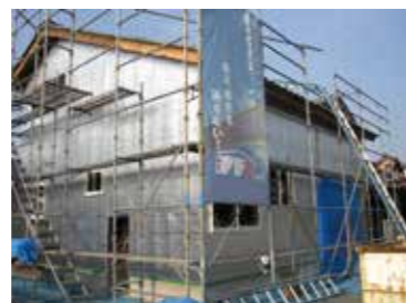
建材アルミプチ® 施工事例
