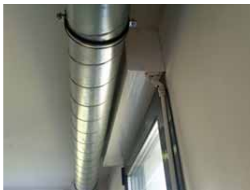
Gaine de ventilation collée/serrée avec le coffre du volet roulant. © Quentin Moureau
