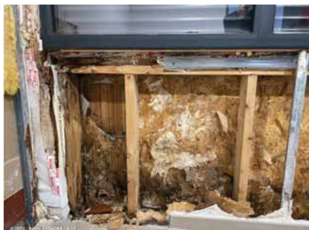
La mauvaise étanchéité de la liaison menuiserie/mur ossature bois a entraîné une accumulation d'humidité à l'intérieur du mur, la dégradation des bois et l'apparition de mэрule. © Rémi Honoré
