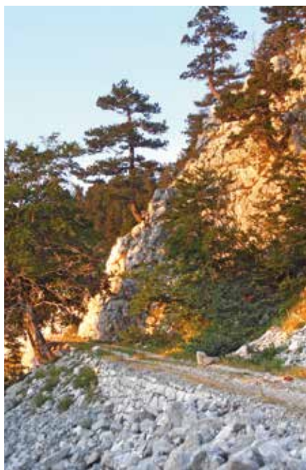
Austro Hungarian macadam road Vrbanj-Orjensko sedlo
