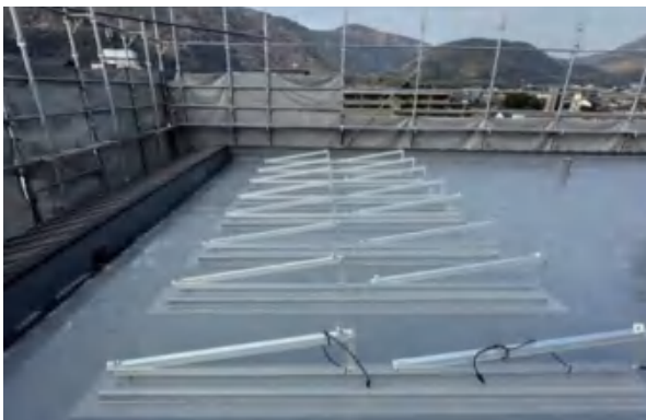
施工写真：陸屋根バラスト架台案件
