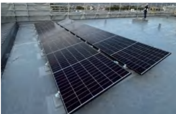
施工写真：陸屋根三角ブラケット架台案件
