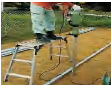
電動ハンマーで杭を地面に打ち込みます
