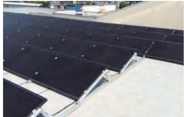
施工写真：陸屋根バラスト架台案件
