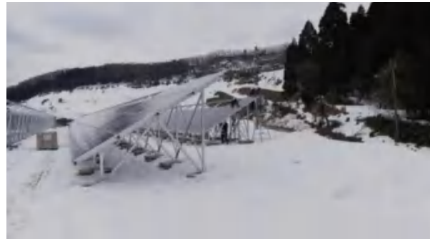
施工写真: 高積雪アルミ野立架台案件
