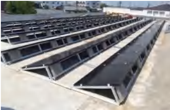
施工写真：陸屋根バラスト架台案件
