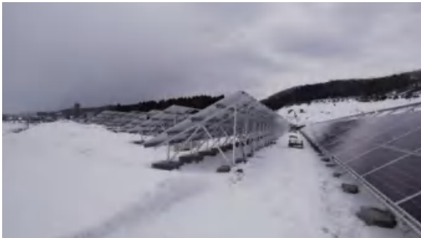
施工写真: 高積雪アルミ野立架台案件
