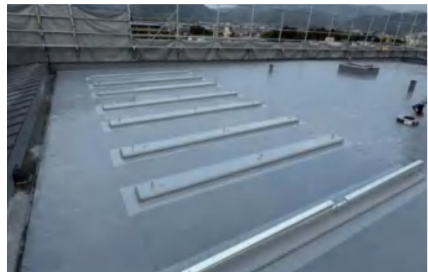
施工写真：陸屋根バラスト架台案件
