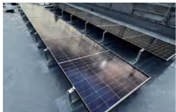
施工写真：陸屋根三角ブラケット架台案件
