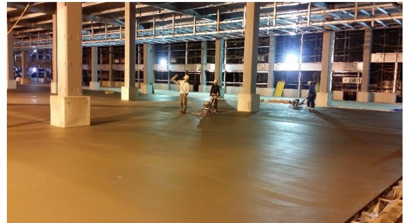
* 最終押え仕上げの作業状況
