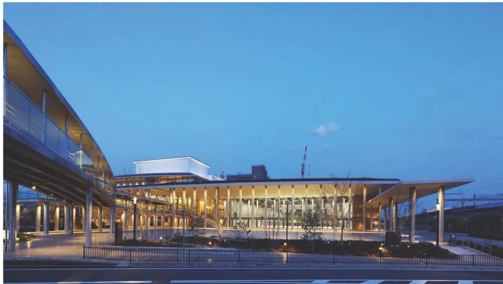
西側からの外観 / Exterior from West side
